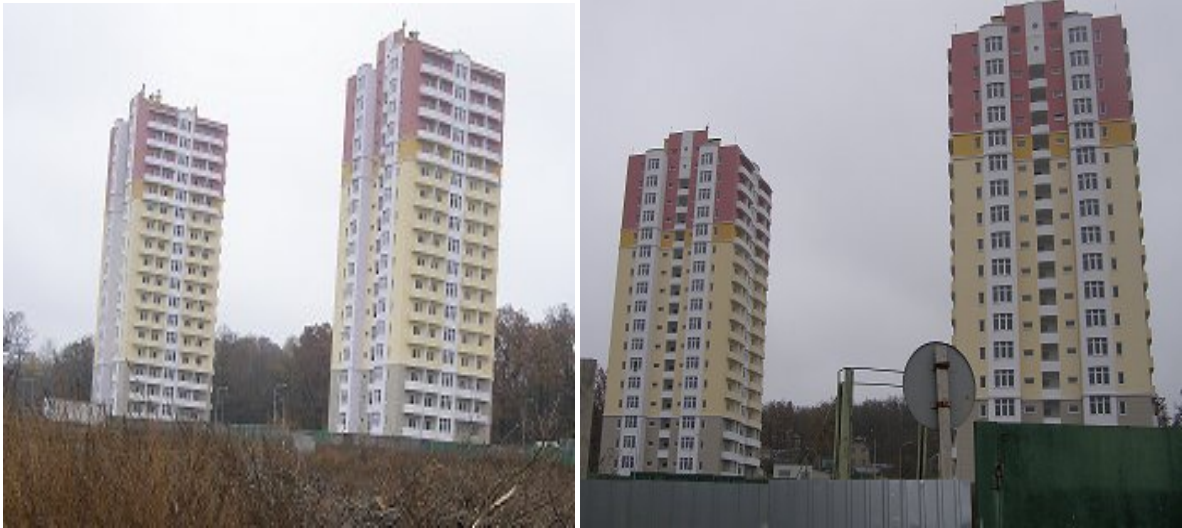
Стан будівництва житлового комплексу Grand Life (будинки № 3, 4, 5, 6) в м. Ірпені Київської області станом на 03.11.2010 р.
